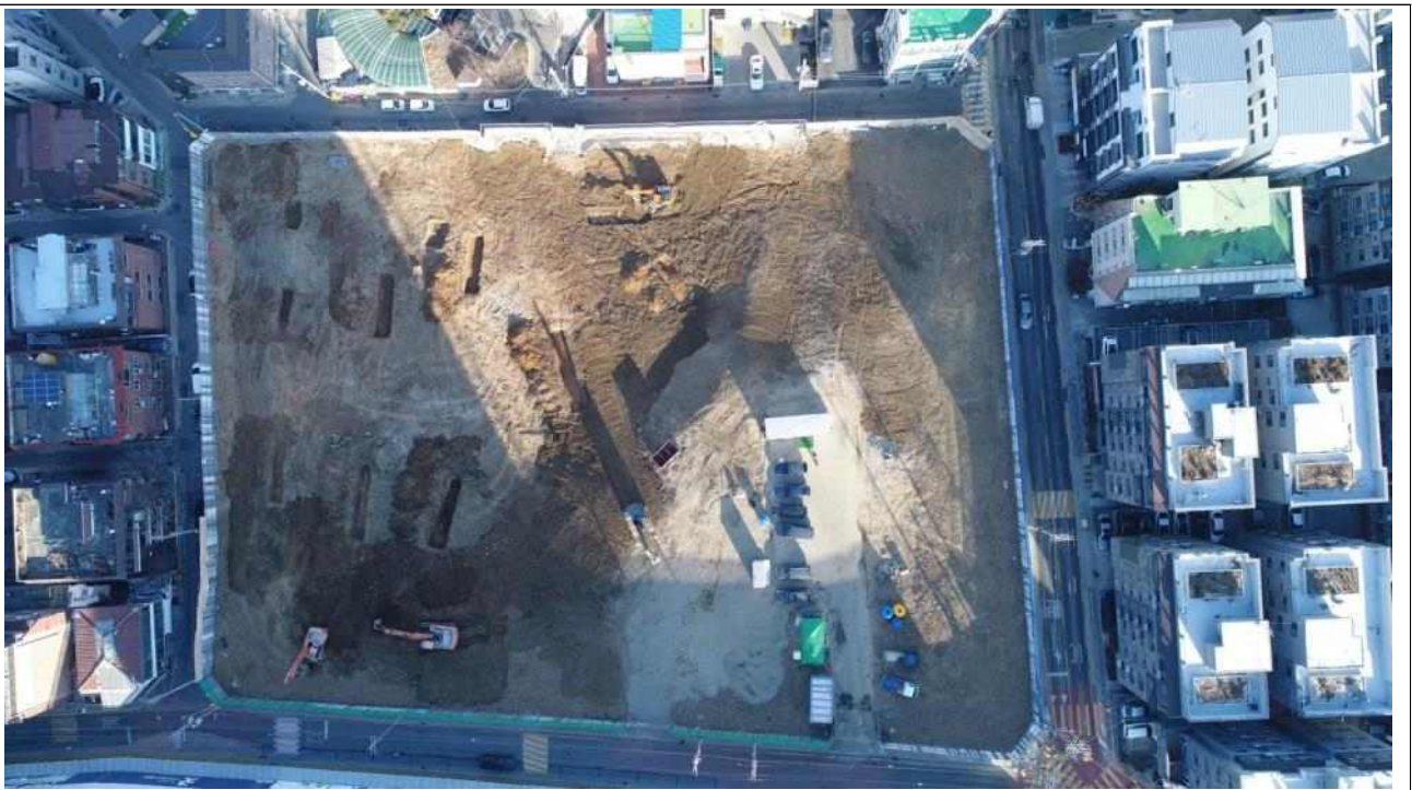
대상지 현황 (철거 완료 상태)
