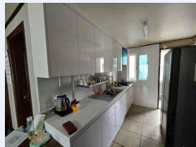
주방시설 정비 후
